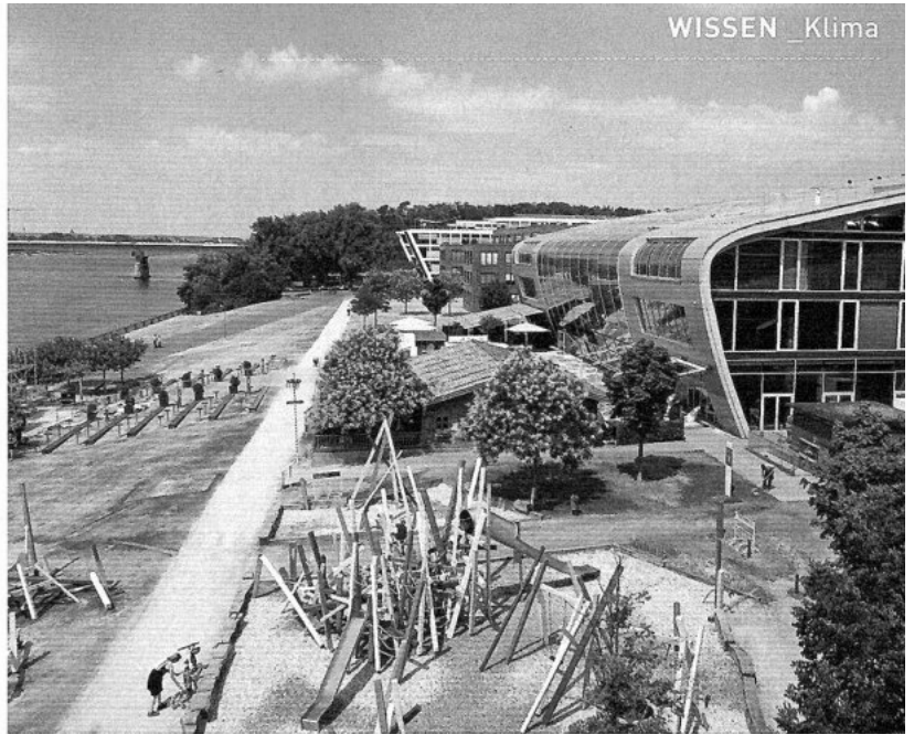
Umweltschonend angelegt: Ein Aquifer-Speicher versorgt zwei Bürogebäude und ein Hotel im Bonner Bogen im Sommer mit Kälte und im Winter mit Wärme.
